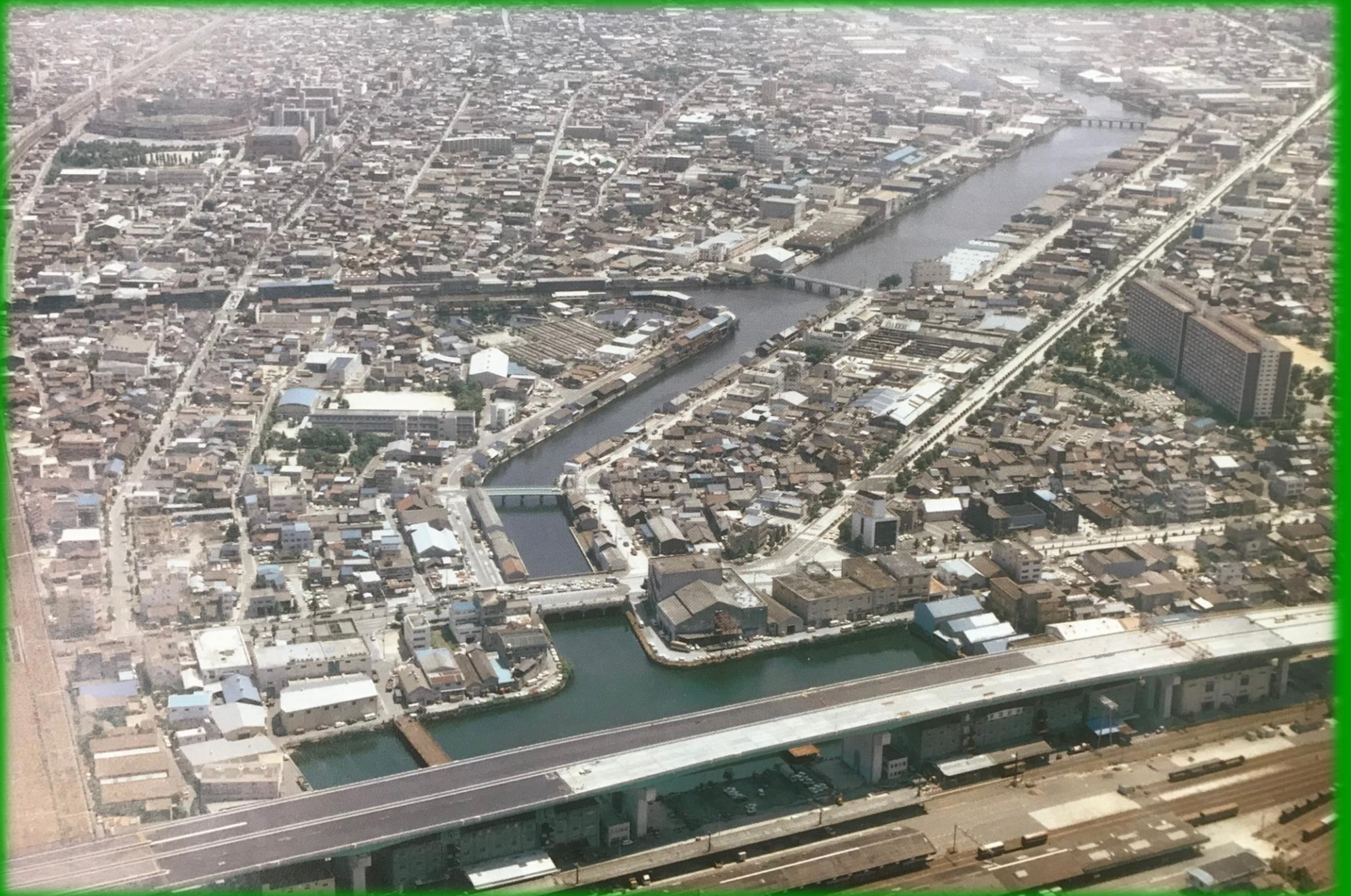
現在のささしまライブ上空から撮影した中川運河 ★出典：『中川区史』昭和62(1987)年発行
