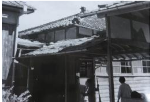
破損した校舎。
