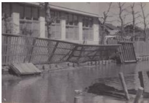
破損した板塀。
