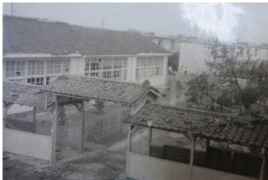
破損した東校舎。
