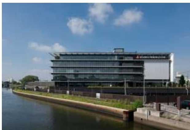
愛知時計電機株式会社 本社ビル（熱田区）
