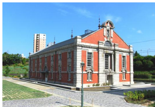
旧第一ポンプ所(鍋屋上野浄水場)
