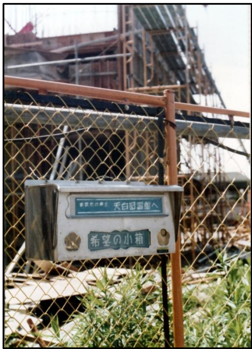
建築現場に設置された「希望の小箱」
